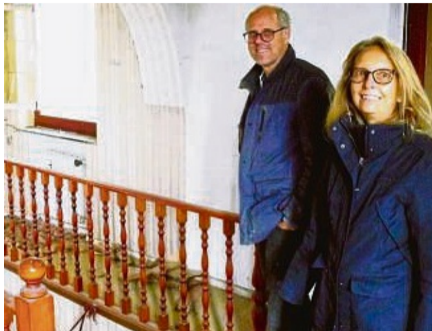
Die Treppe muss weg: Winfried und Simone Gann wollen den Ursprung des Gebäudes wieder herstellen, deshalb wird diese Treppe wieder entfernt.
